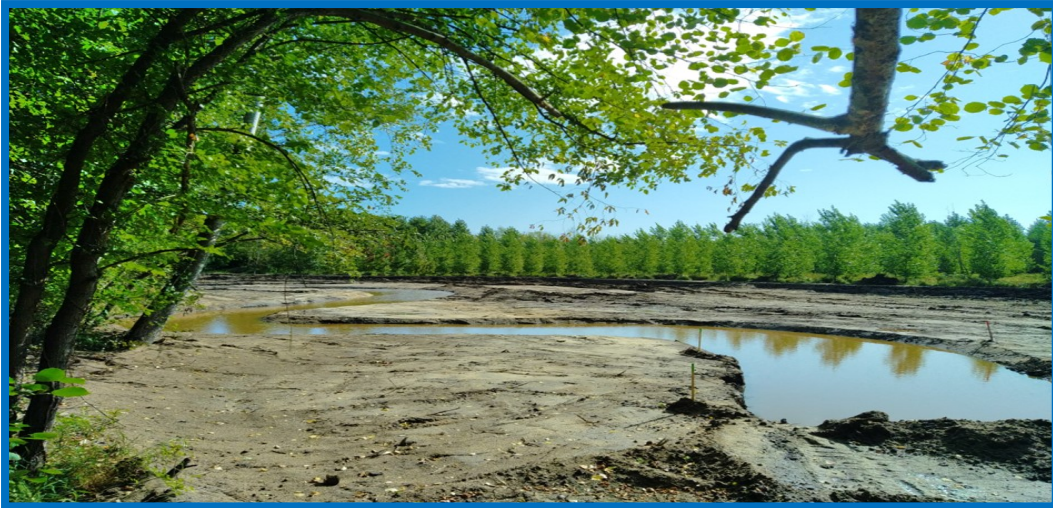
Reméandrage en cours de terrassement – Crédit photo : SMBVJCC
