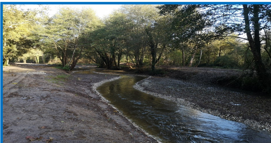
Nouveau lit de la Jalle de Tiquetorte à la mise en eau Crédit photo : Equo Vivo
