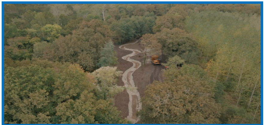
Nouveau lit de la Jalle à l'emplacement de l'ancien seuil de Tiquetorte Crédit photo : GreenCap Studio / Equo Vivo
