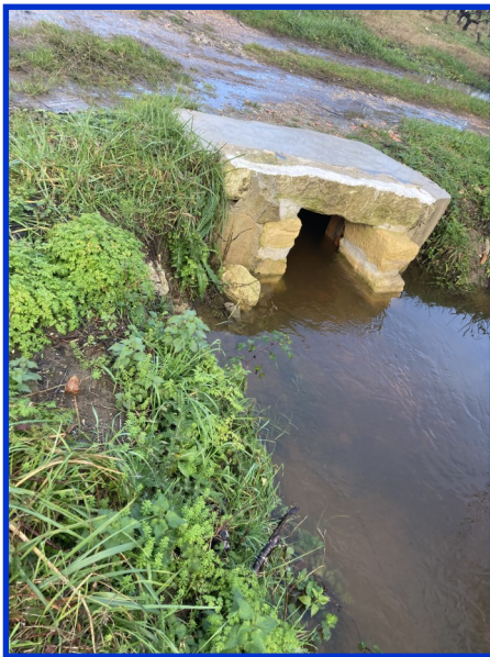
Réparation du pont du cours d'eau la Tamponnette chemin des Fontanelles
